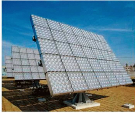
図表 14 集光型太陽光発電システム例
