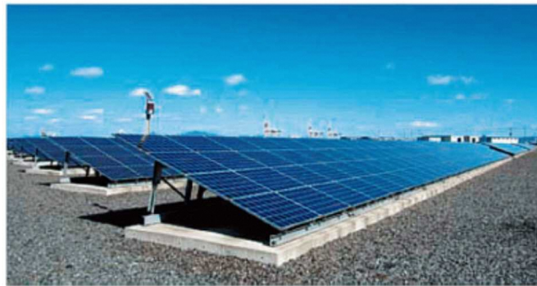
図表 12 平置き型太陽光発電システム例
