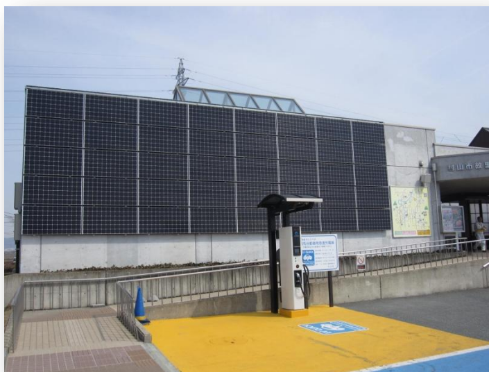
道の駅むらやまの太陽光発電と電気自動車の急速充電器
