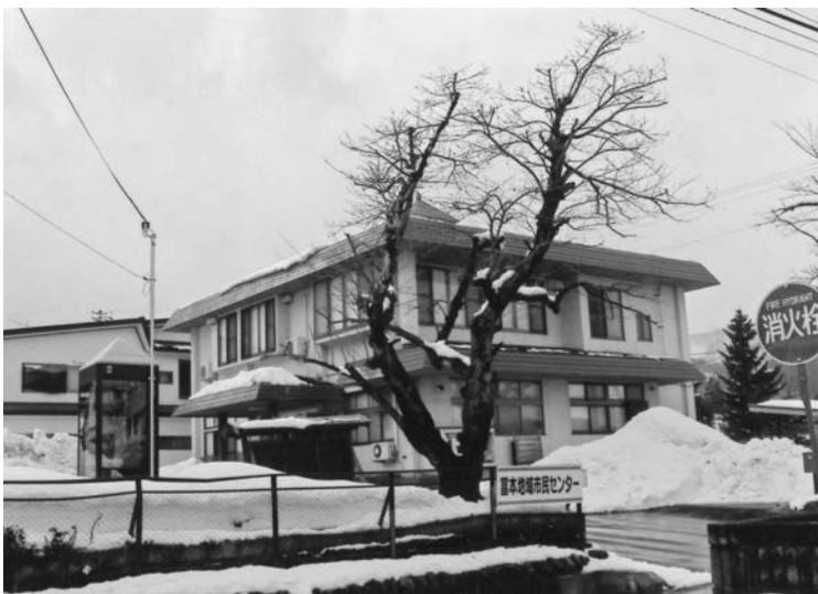
耐震化工事入札で2回不調となった富本地域市民センター
