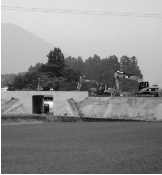
工事が進む東北中央自動車道（名取地区）
