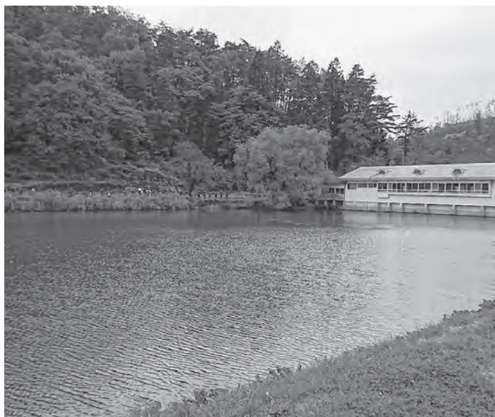
安全性を配慮して使われていない貴重な資源を活かしていく
