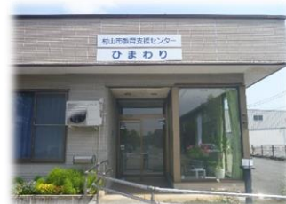
令和 5 年度新設施設
