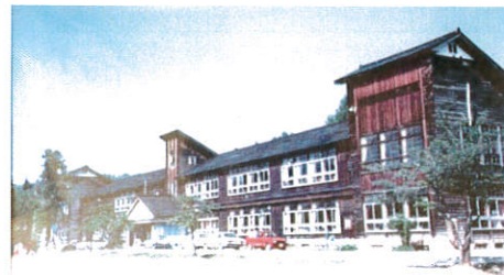
1947年（昭和22年）に建てられた新校舎
