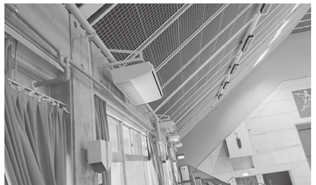
エアコンが設置された村山市民体育館
