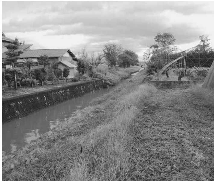
台風19号の大雨により増水した浮沼地区赤助川
