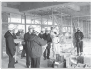
改装工事中の Link MURAYAMA 内部
