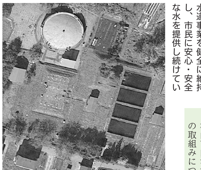
災害時の自己水源調査を行う楯岡浄水場 (上空図)
