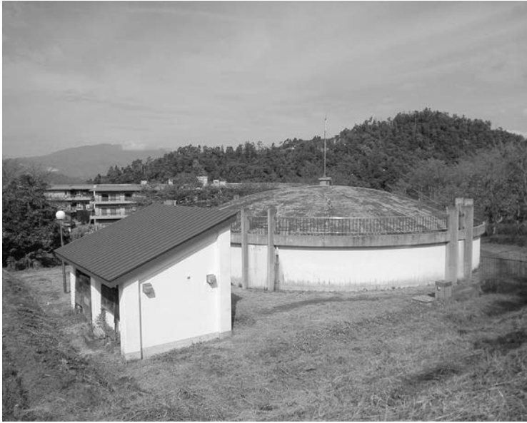
楯岡低区配水池（楯岡笛田地内）
