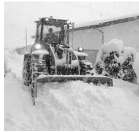
市民が快適に暮らすための除雪作業
