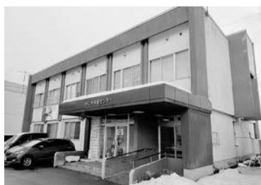
建設から40年が経過した保健センター
