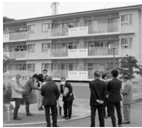
北杜市営子育て支援住宅
