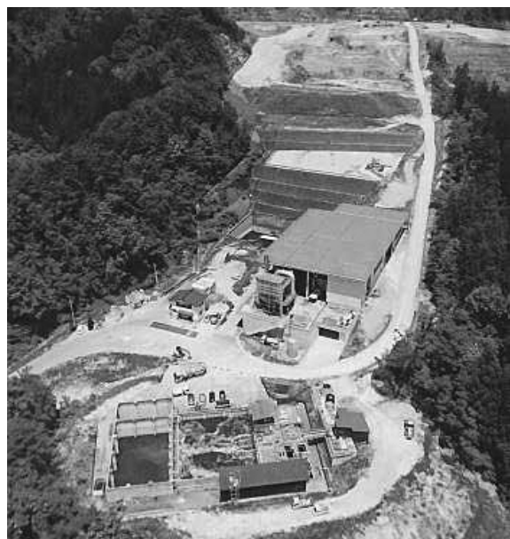
村山西部産業廃棄物最終処分場の全景
