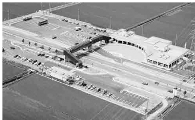
現・道の駅むらやま全景
