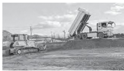
載荷重工法で地盤を沈圧中
