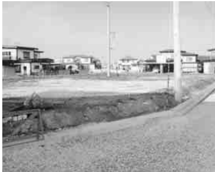
改良が進む市道俵町北線
