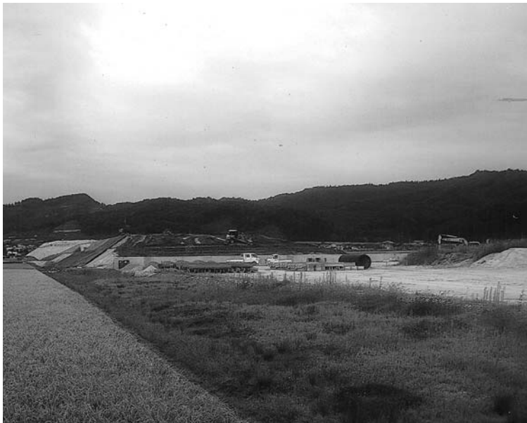
東北中央自動車道盛土状況
