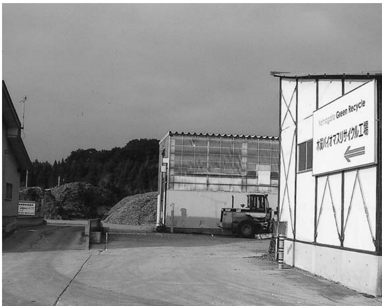
バイオマス発電用チップ工場
