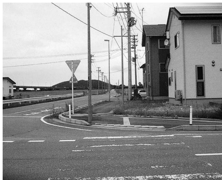
未整備の鶴ヶ町西線（前方）
