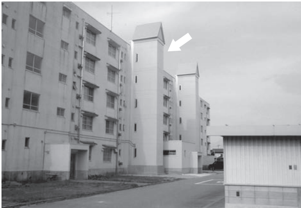
北町の定住促進住宅へのエレベーター設置
