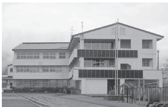
太陽光発電パネル7kw 蓄電池10kWh
