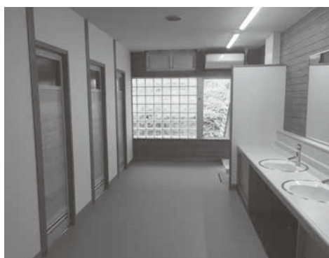
完成したシャワールーム
