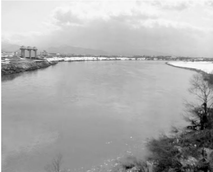
雪どけ水で増水した最上川（大旦川水門付近）
