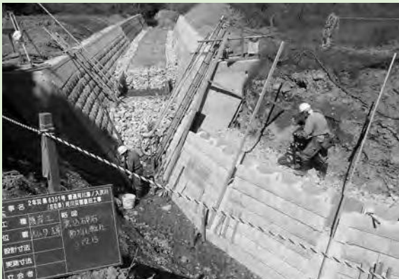
湯ノ入沢川災害復旧工事の様子 (R3.10)
