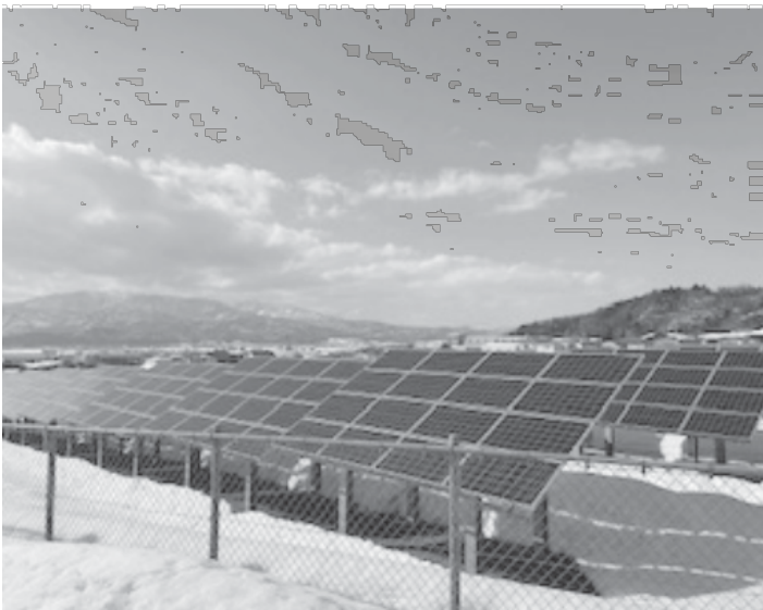
福岡笛田にある太陽光発電所 (一般家庭310戸分の年間消費電力を発電)
