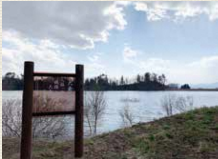
土地改良区が管理する大倉ため池
