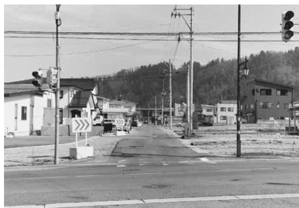
令和5年度県道の交差点から約100mの区間の道路改良工事を行う市道本郷通り線
