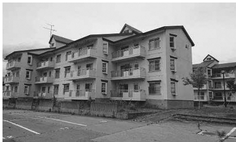
市営楯岡中町住宅
