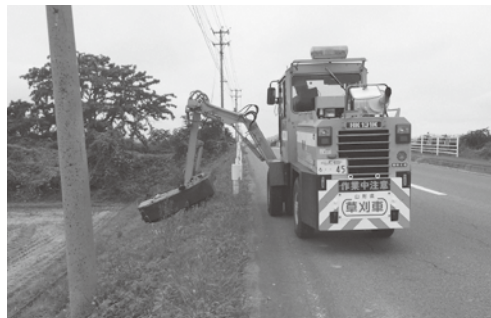
ロータリー車による草刈作業
