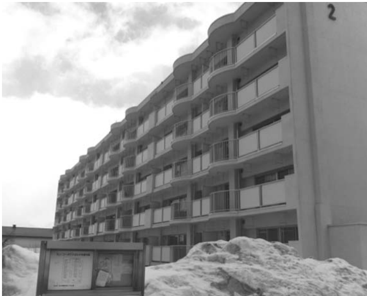
避難所として緊急活用が要望された雇用促進住宅
