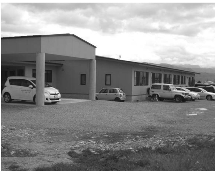
新設された「はやまホーム」
