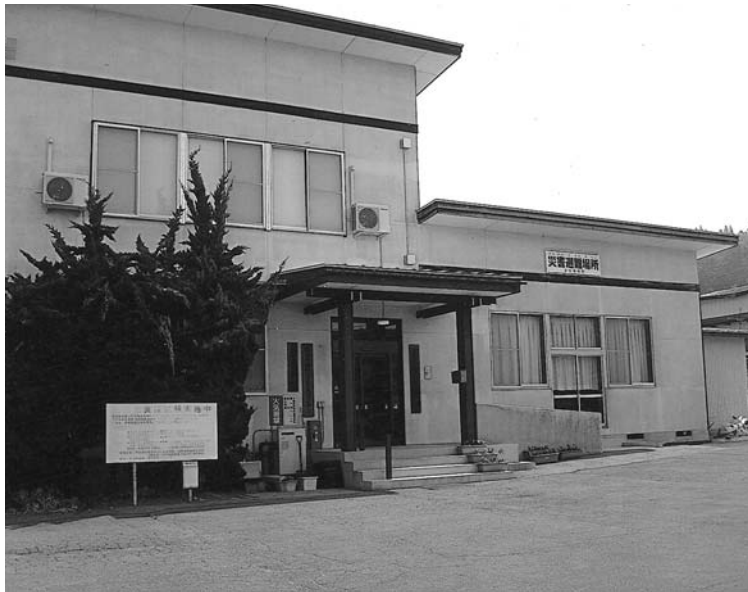
避難所に指定されている市民センター
