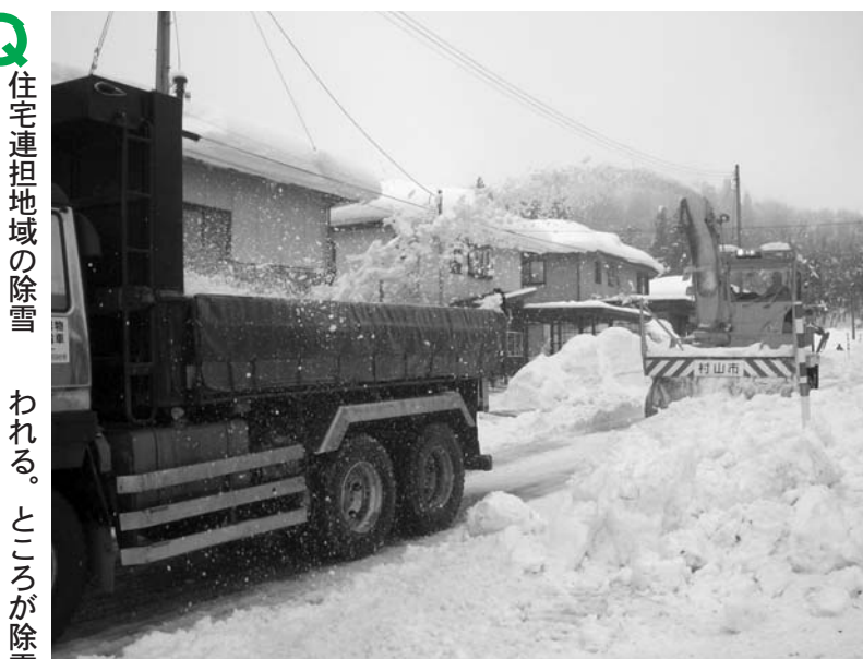
県・市・住民による共同除排雪（河島山ニュータウン）
