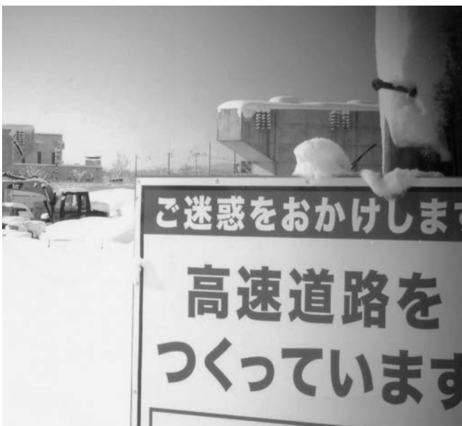
急ピッチで工事が進む高速道路
