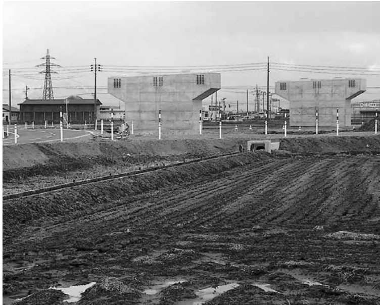
完成が間近な東北中央自動車道
