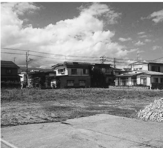
造成中の楯岡二日町ミニ住宅団地
