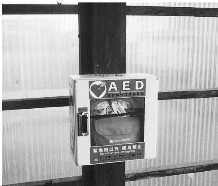
屋外に設置しているAED
