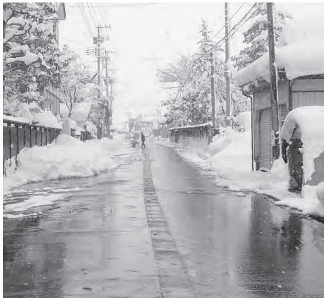
市内の消雪施設道路
