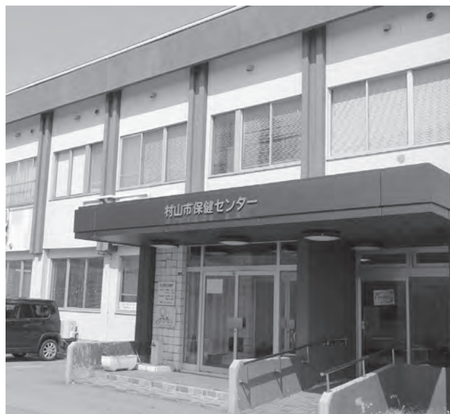
老朽化した保健センター
