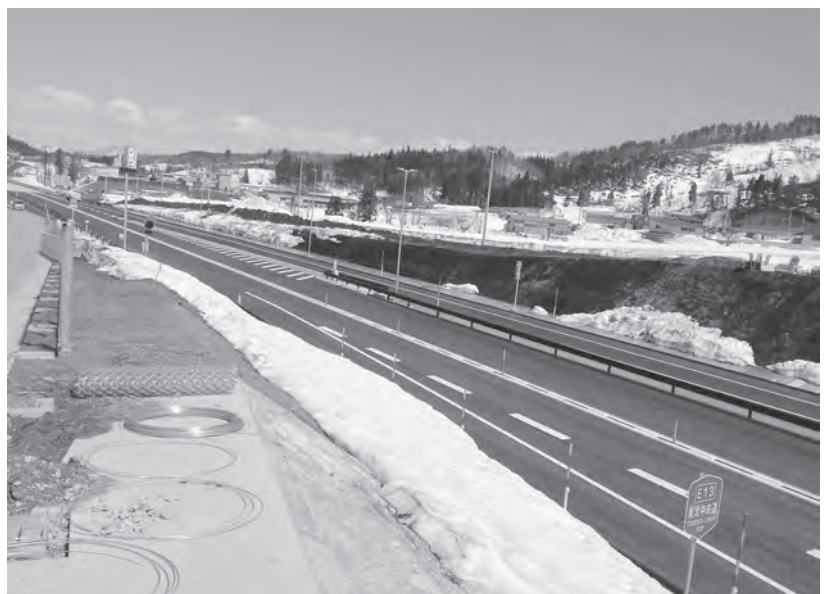
開通した大石田村山インター周辺
