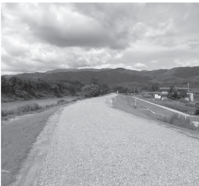
前期工事が完成した長島地区堤防
