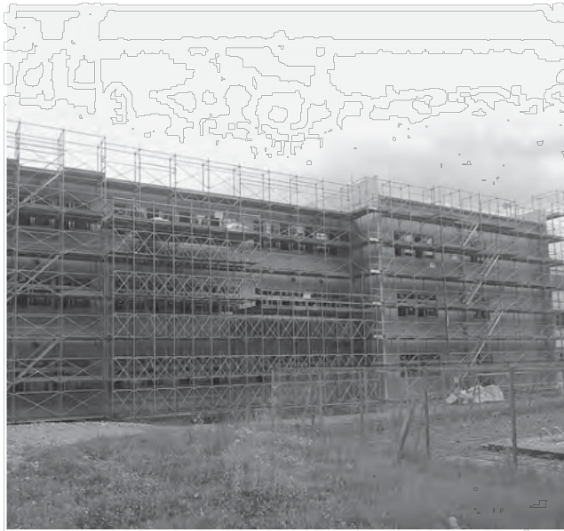
改築が進む楯岡小学校校舎
