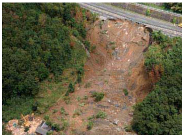
図-1 山陽自動車道での盛土のり面崩壊
