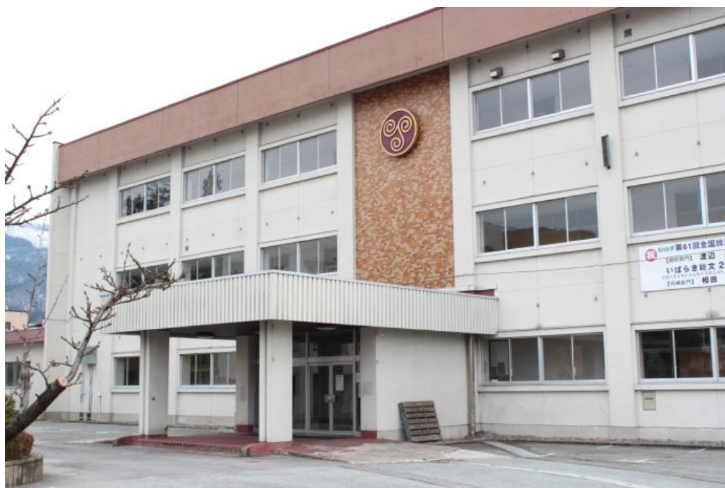
〔旧楯岡高等学校跡地 管理棟外観〕
