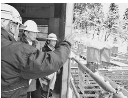
工事監査の様子
