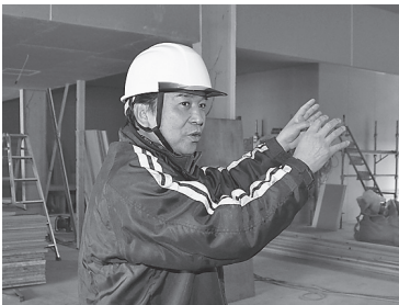
改装工事現場で指示をする田中代表
