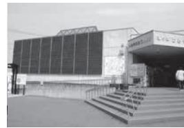
道の駅むらやま パネル9.32kW 蓄電池15kWh
