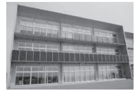
葉山中学校 パネル5.76kW 蓄電池 5 kWh
