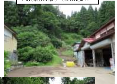
土砂流出の様子（新田地区）
